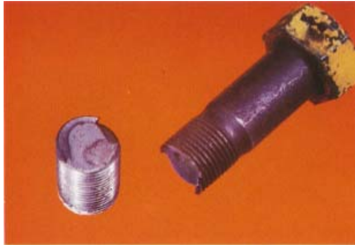
Este bulón de vía también experimentó una fractura por corrosión por tensión.
