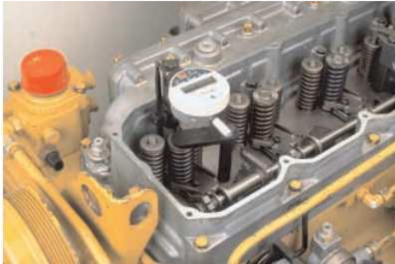
Fig. 4.4.5 Instalación del indicador digital
