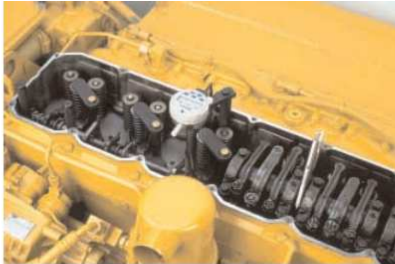
Fig. 4.3.8 Instalación del indicador digital
